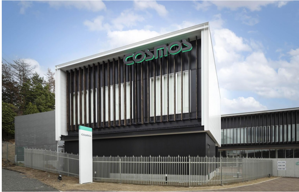
火災実験室PLUSCO Lab. (プラシオラボ) 開所 (2023年5月)
